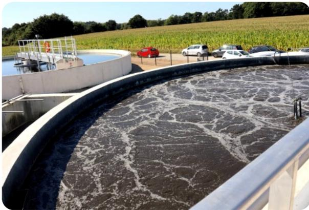
Mesure d'oxygène dissous en bassin d'aération
