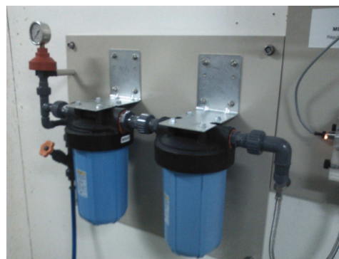
Exemple de préfiltration (poche 10µm + cartouche plissée 5µm)
